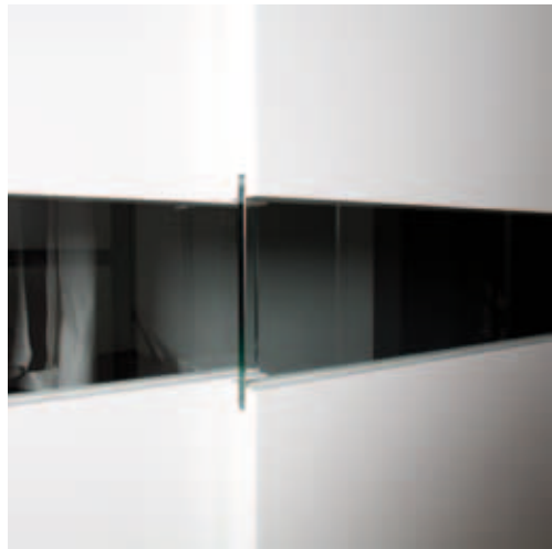
Dettaglio vetro strutturale. Detail of the structural glass.
